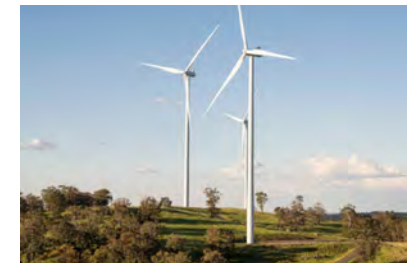
「Sapphire Wind Farm」はCWP Renewables(当時)が運用するニューサウスウェールズ州で最大の風力発電所
