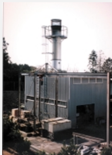
廃止した焼却施設(沼津工場)
