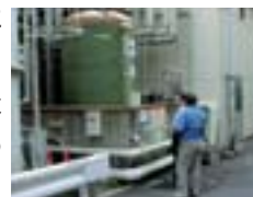
薬品供給タンク防液堤(漏洩防止)の点検
