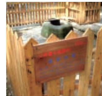
廃パレットを加工した安全柵
