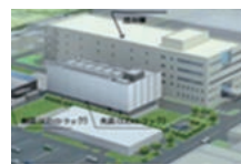
明石システムセンターの外観
